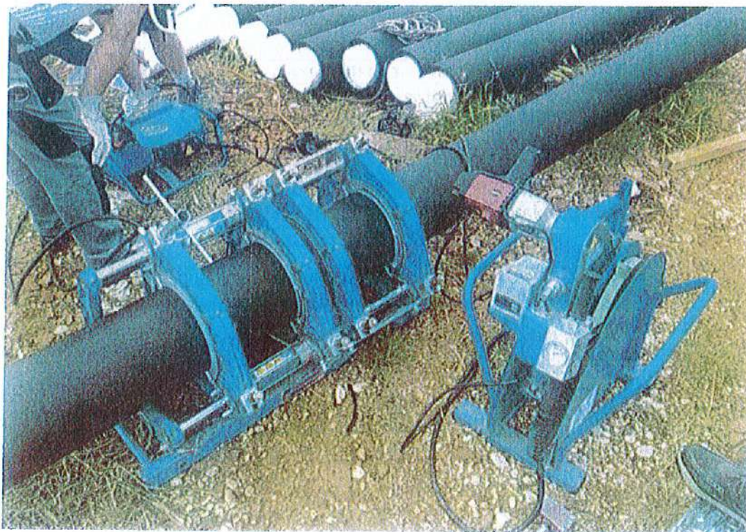
Slika 7. Sučeono varenje PE cijevi
