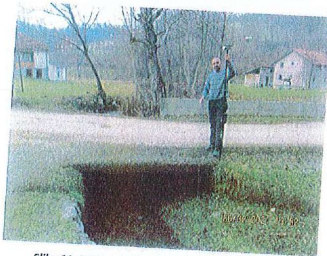
Slika 11: Mjesto prelaza cjevovoda ispod vodotoka
